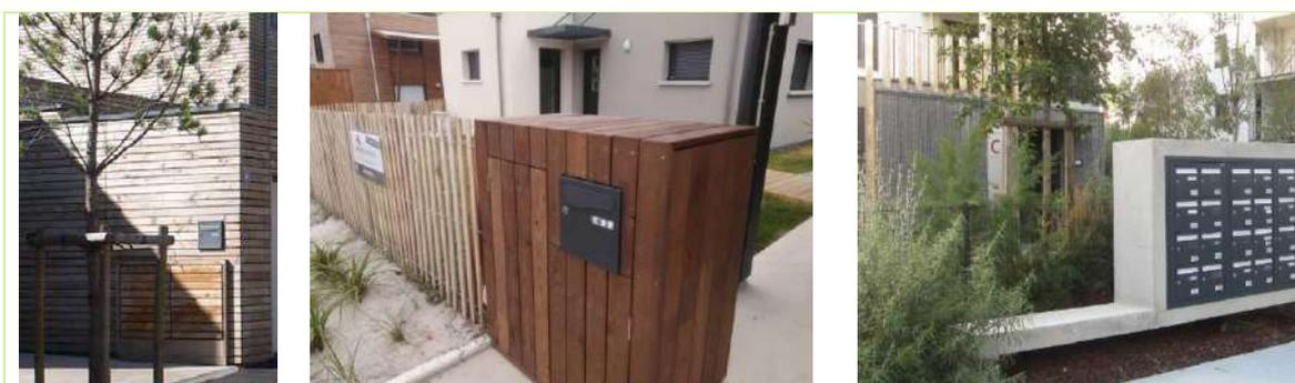
Image 43 - Intégration des éléments techniques dans la clôture
